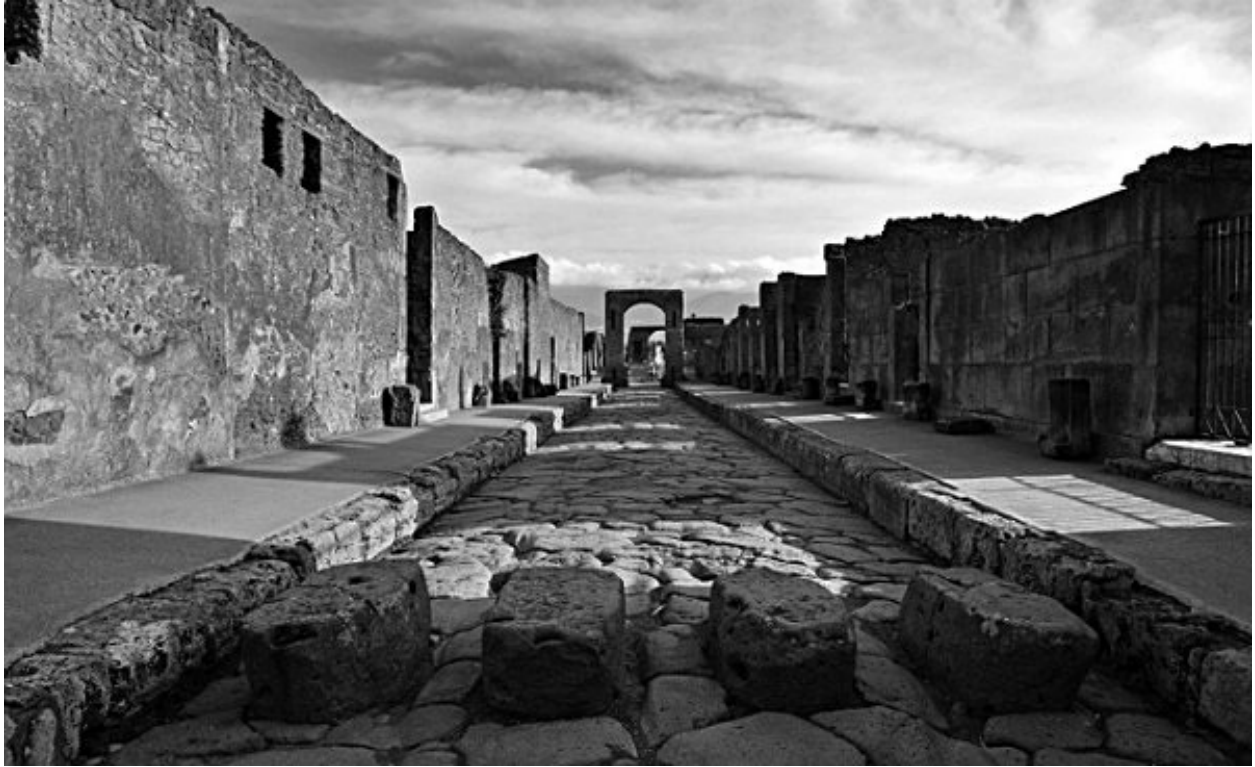
Paso de cebra romano realizado en piedra en una calle de Pompeya, mucho más efectivo que los actuales, solo pintados.
